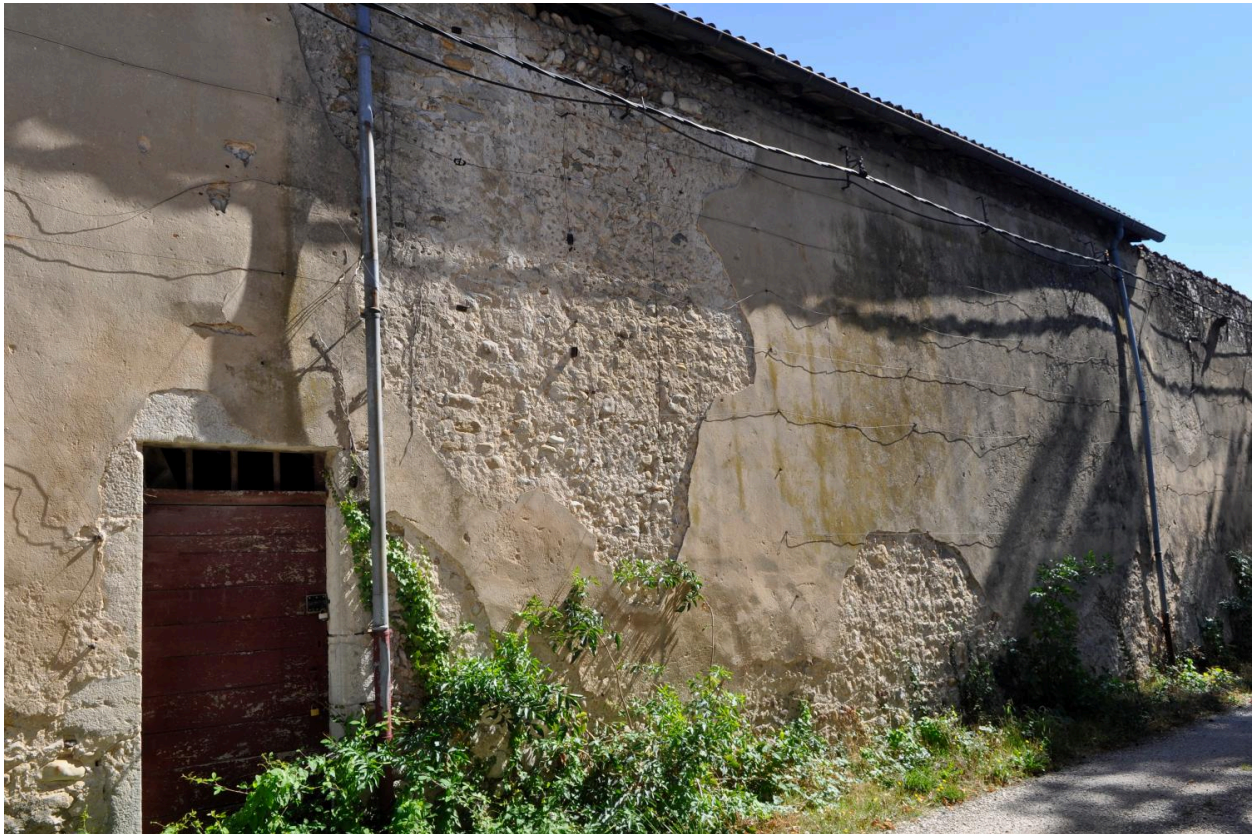
Portion de mur enclavée entre la maison du jardinier et l'orangerie, maçonnerie de galets
