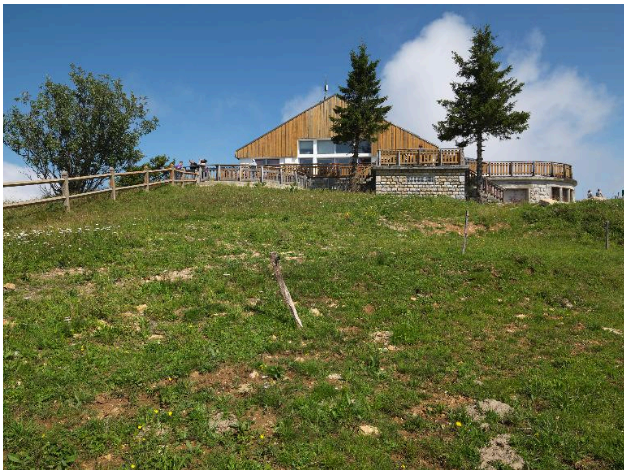
Vue d'ensemble : pignon sud et terrasse du restaurant
