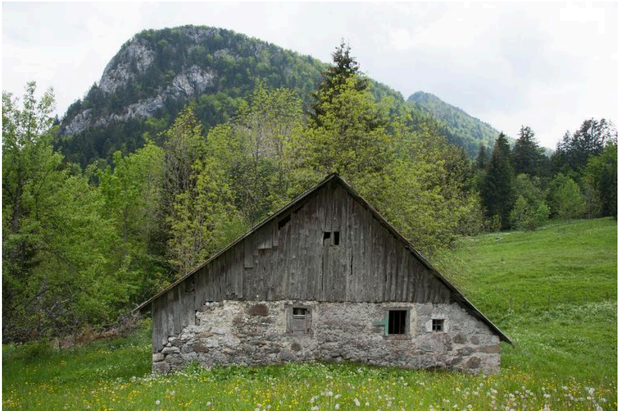
Vue du pignon nord.
