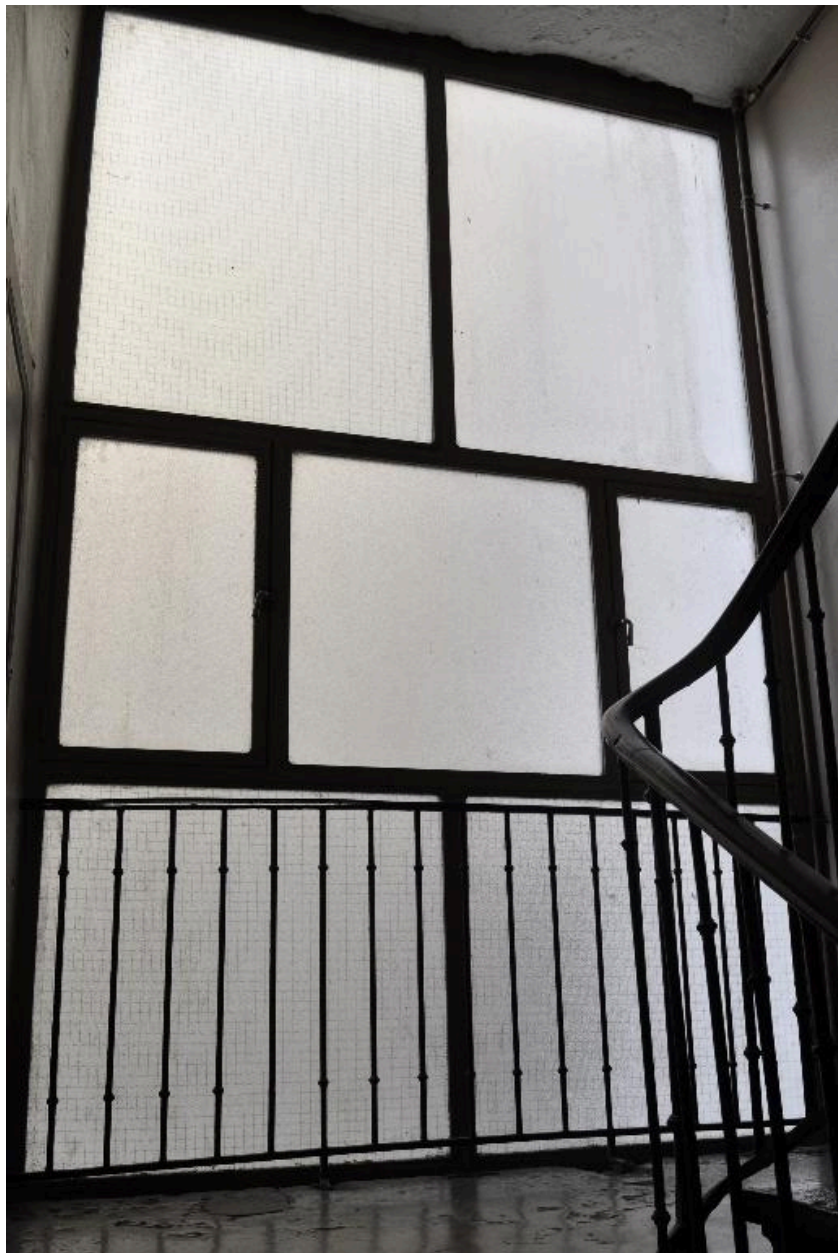
Vitrage fermant la cage d'escalier
