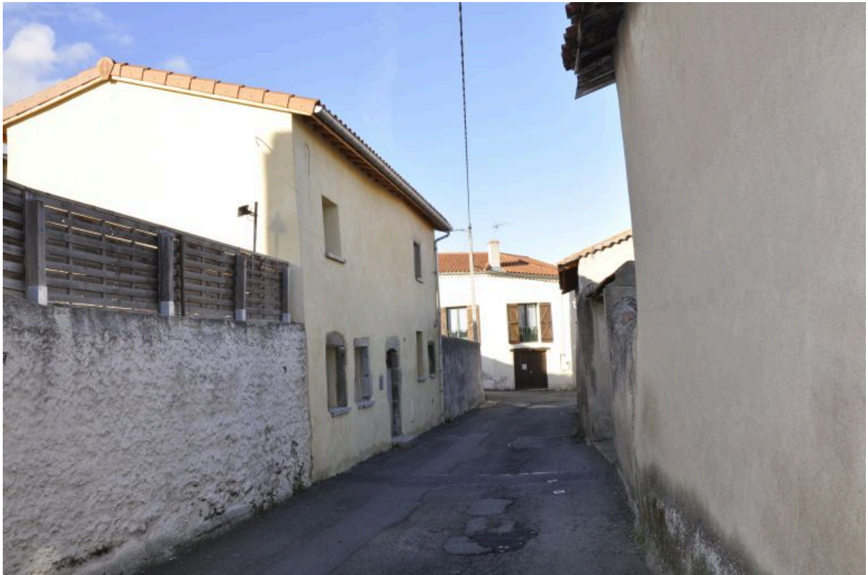
1986 AE 327, 328. 2 rue de la Résistance. Ancienne ferme, vue d'ensemble de l'élévation sur rue.
