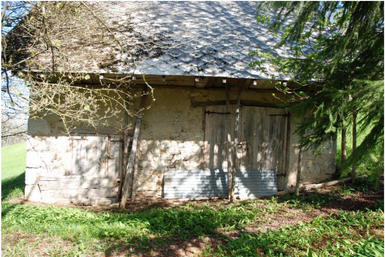
Vue d'ensemble de la façade principale.
