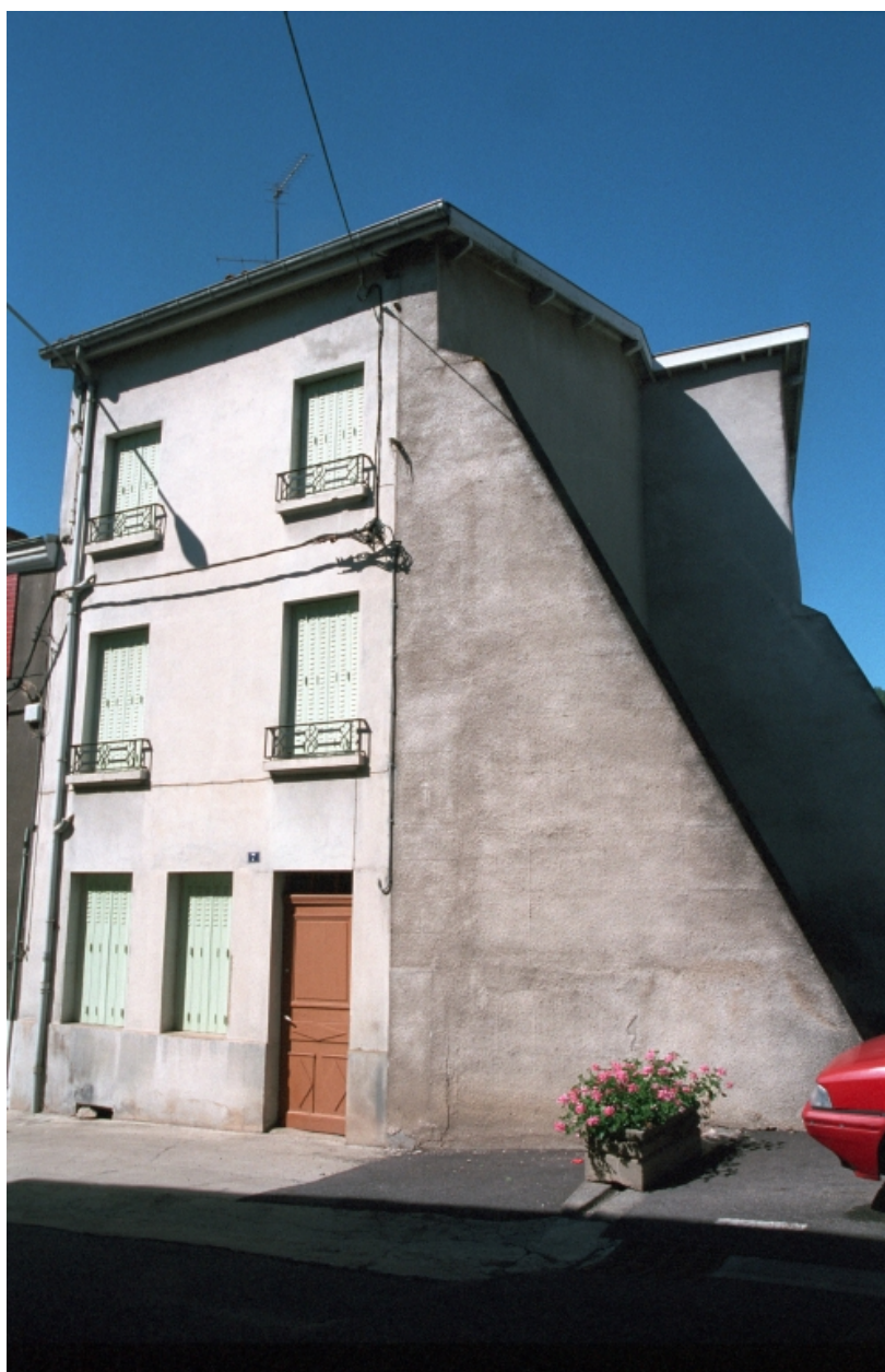
Boën, îlot 13, Gustave Labrosse (rue) 7. Vue générale de la façade sur rue.
