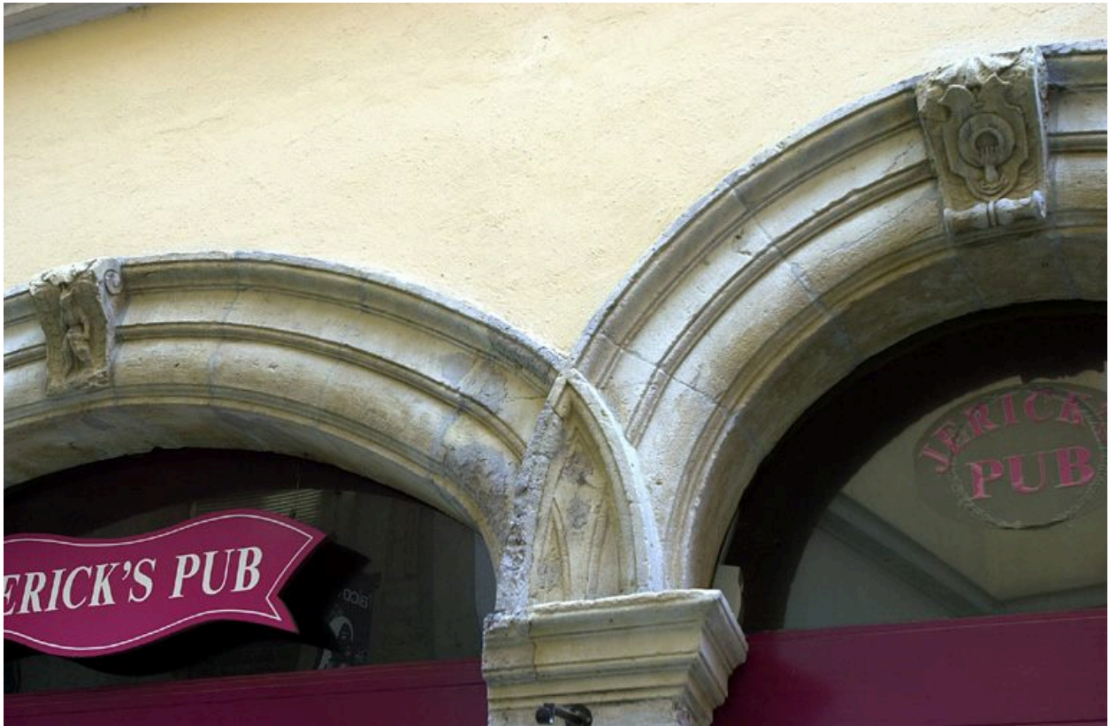
Elévation rue de la Monnaie, rez-de-chaussée : intersection des arcs
