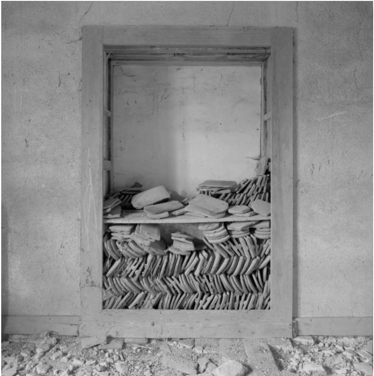
Détail d'un placard rempli de tuiles, dans les combles.
