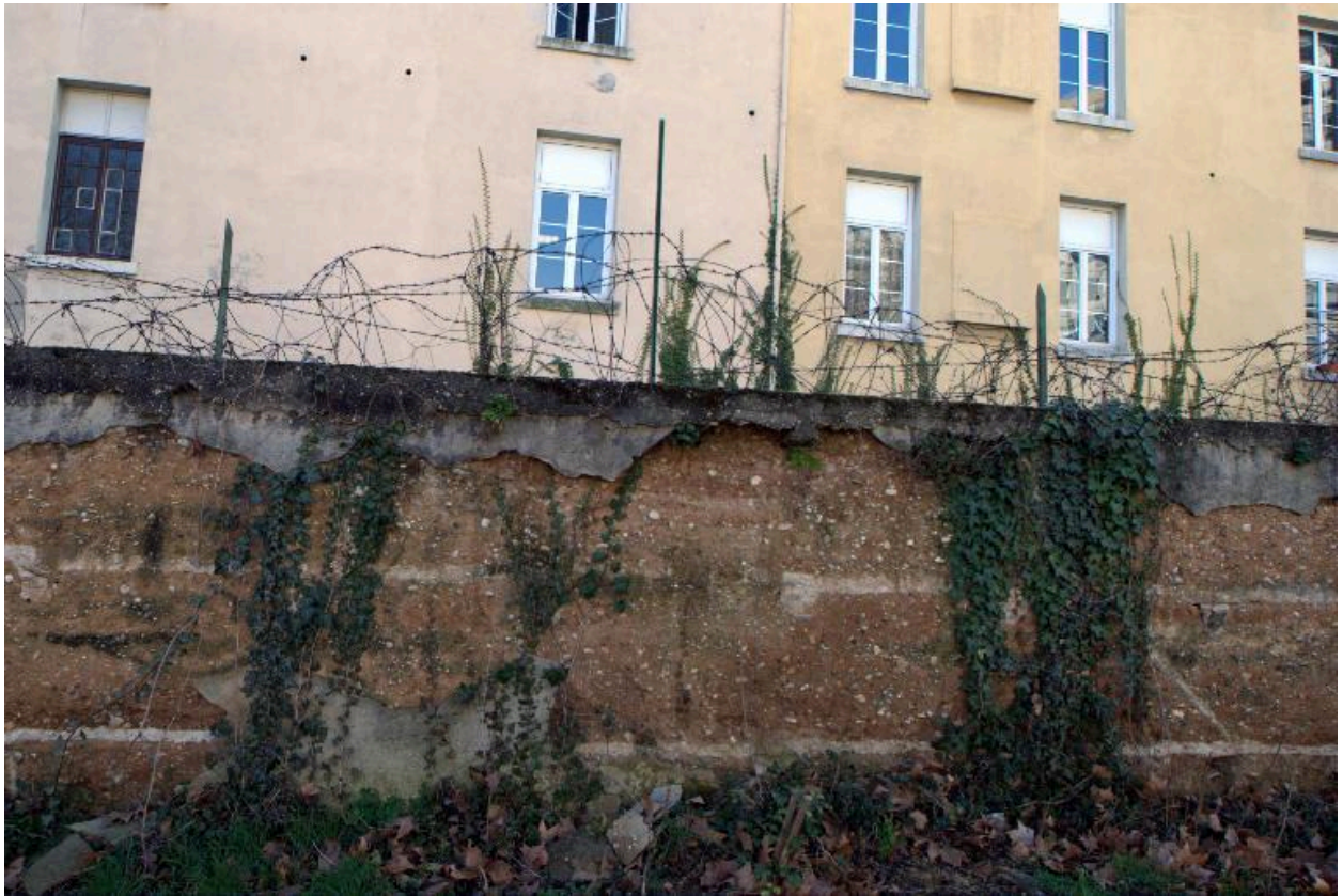
Mur de clôture en pisé, autre détail
