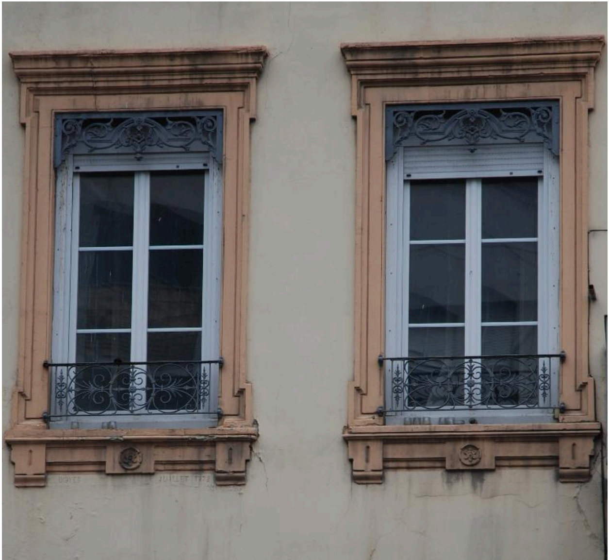
Élévation nord : encadrement des fenêtres du premier étage
