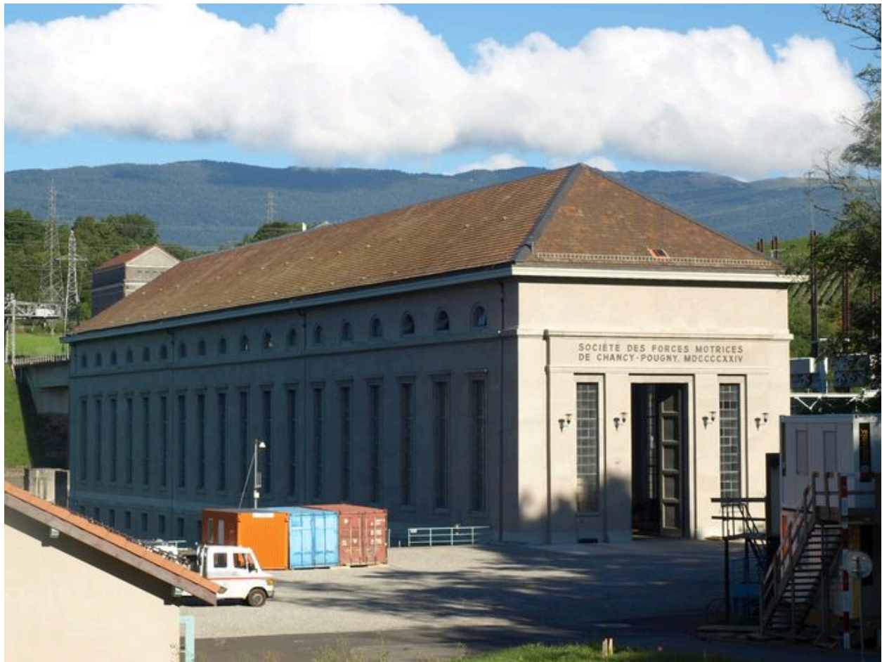
Vue du bâtiment d'usine (depuis la rive gauche)
