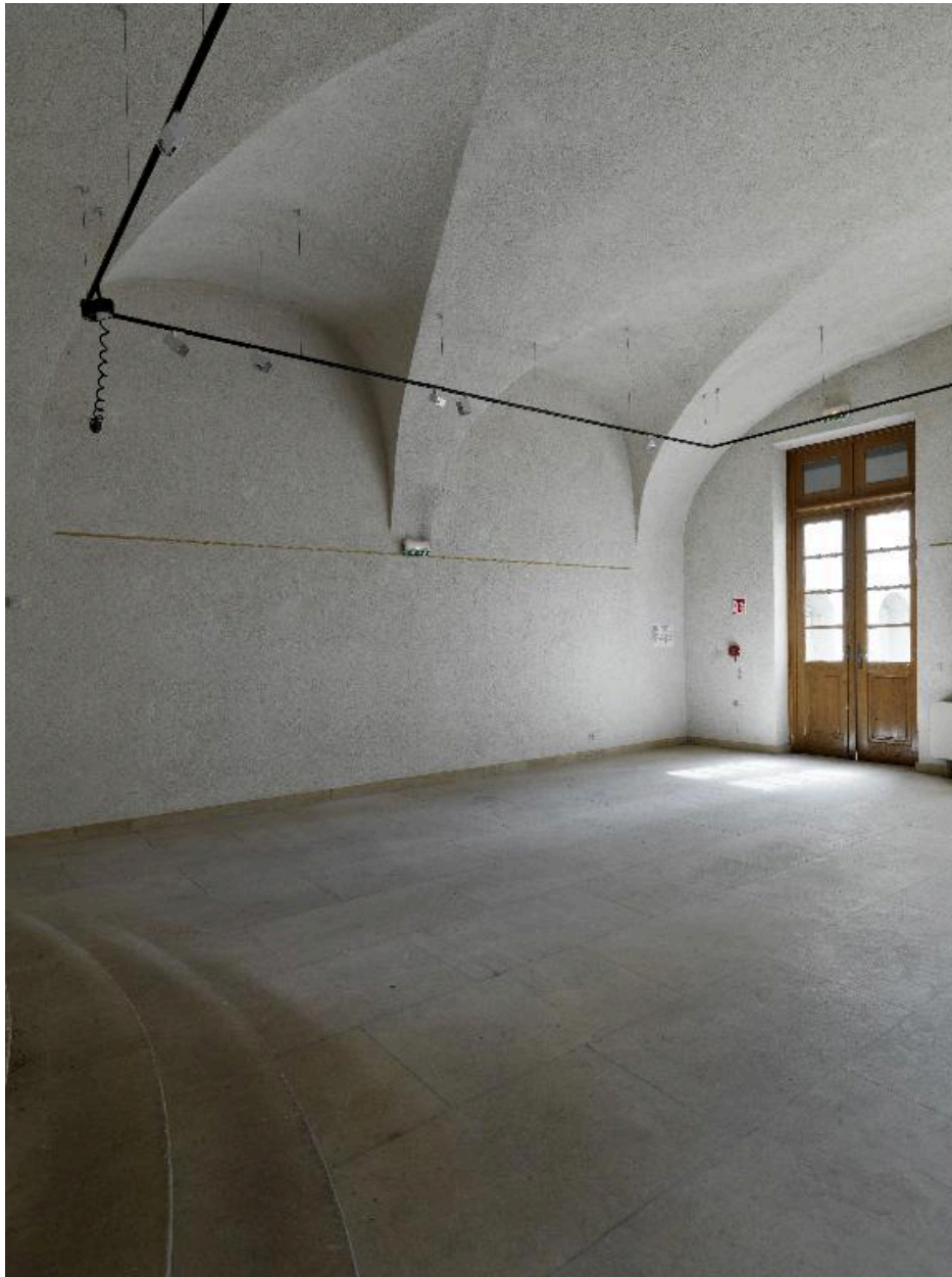
Vue du rez-de-chaussée : ancien choeur des religieux
