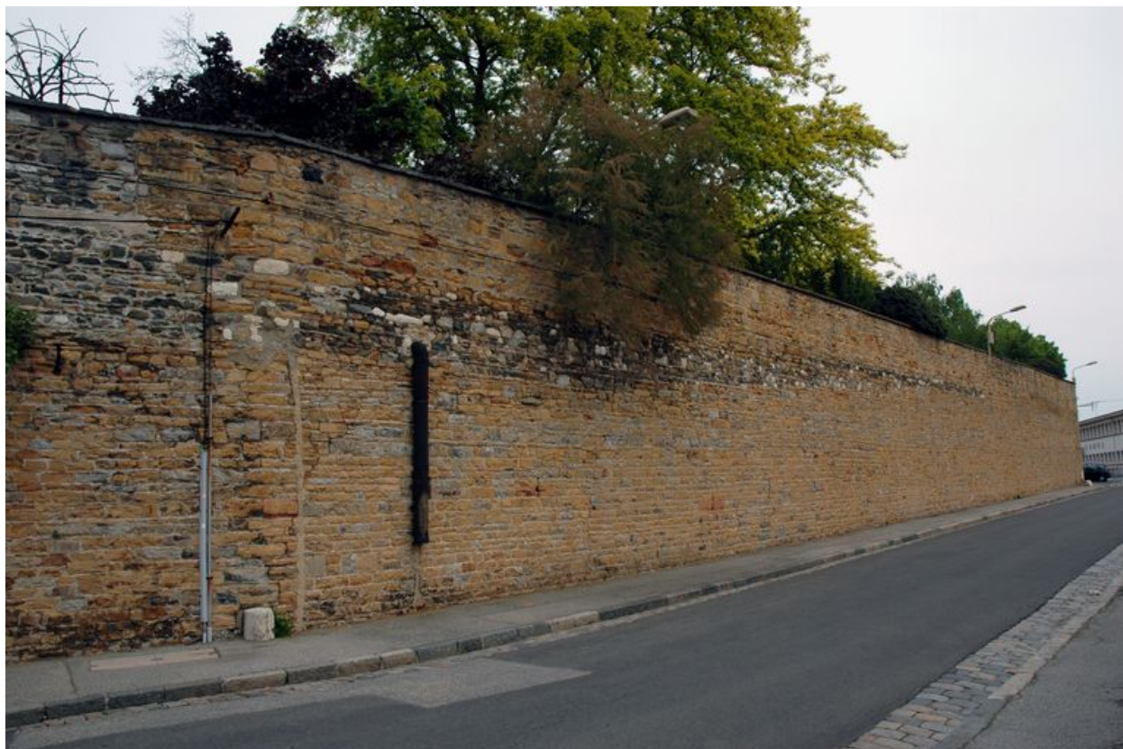
Mur de clôture sud-ouest depuis l'ouest
