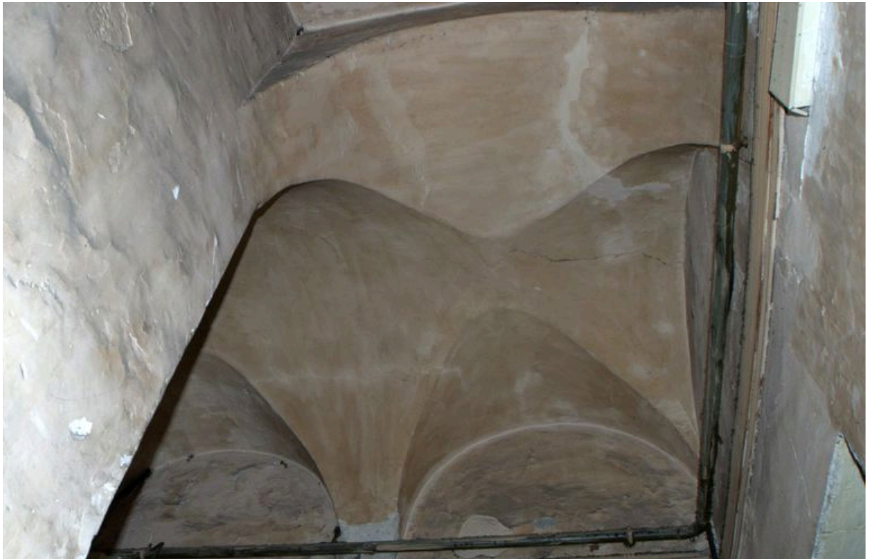
Cage d'escalier, vue de la voûte au niveau du 1er palier
