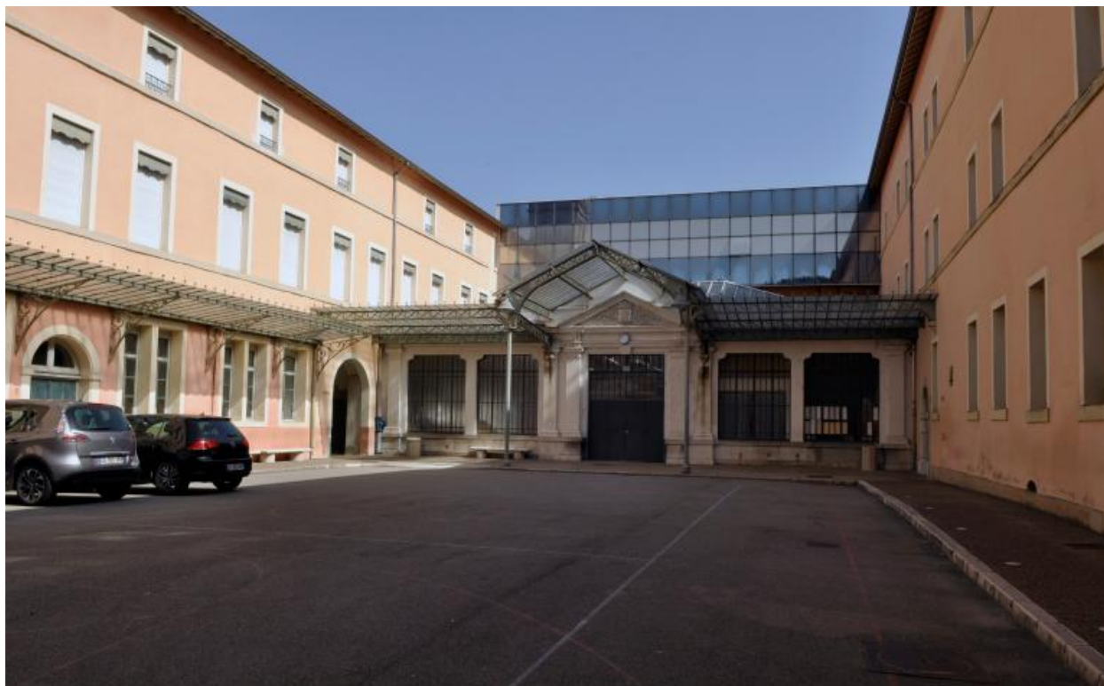
Cour 2 : vue d'ensemble depuis le sud
