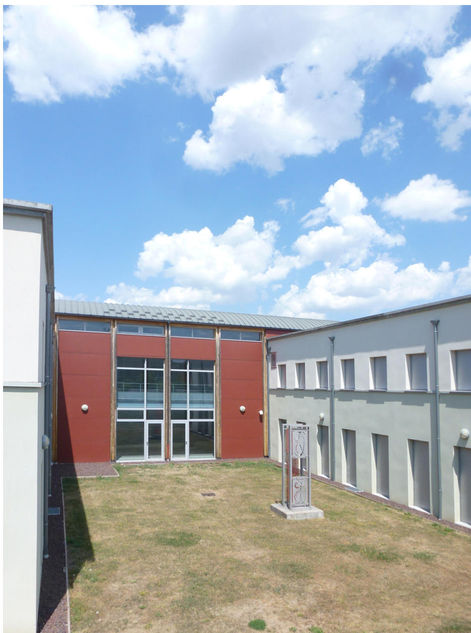
Installation n°3 : vue d'ensemble
