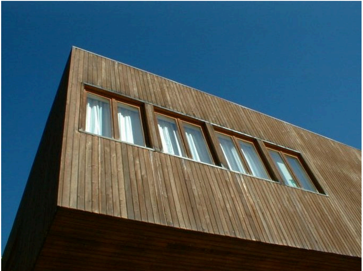
Détail de la façade nord-ouest
