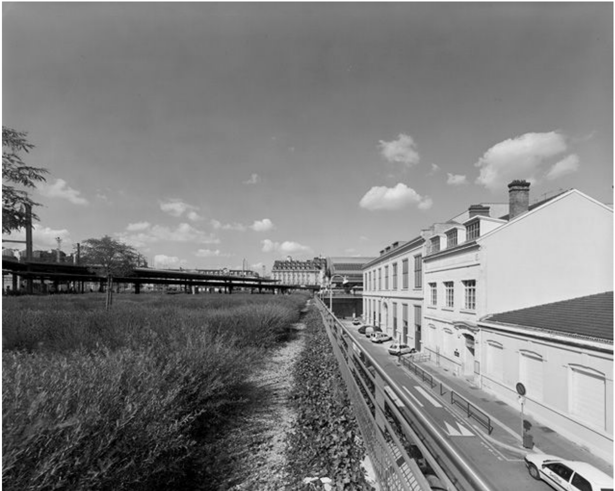
Vue de situation de la façade de la rue Gilibert depuis la plateforme SNCF
