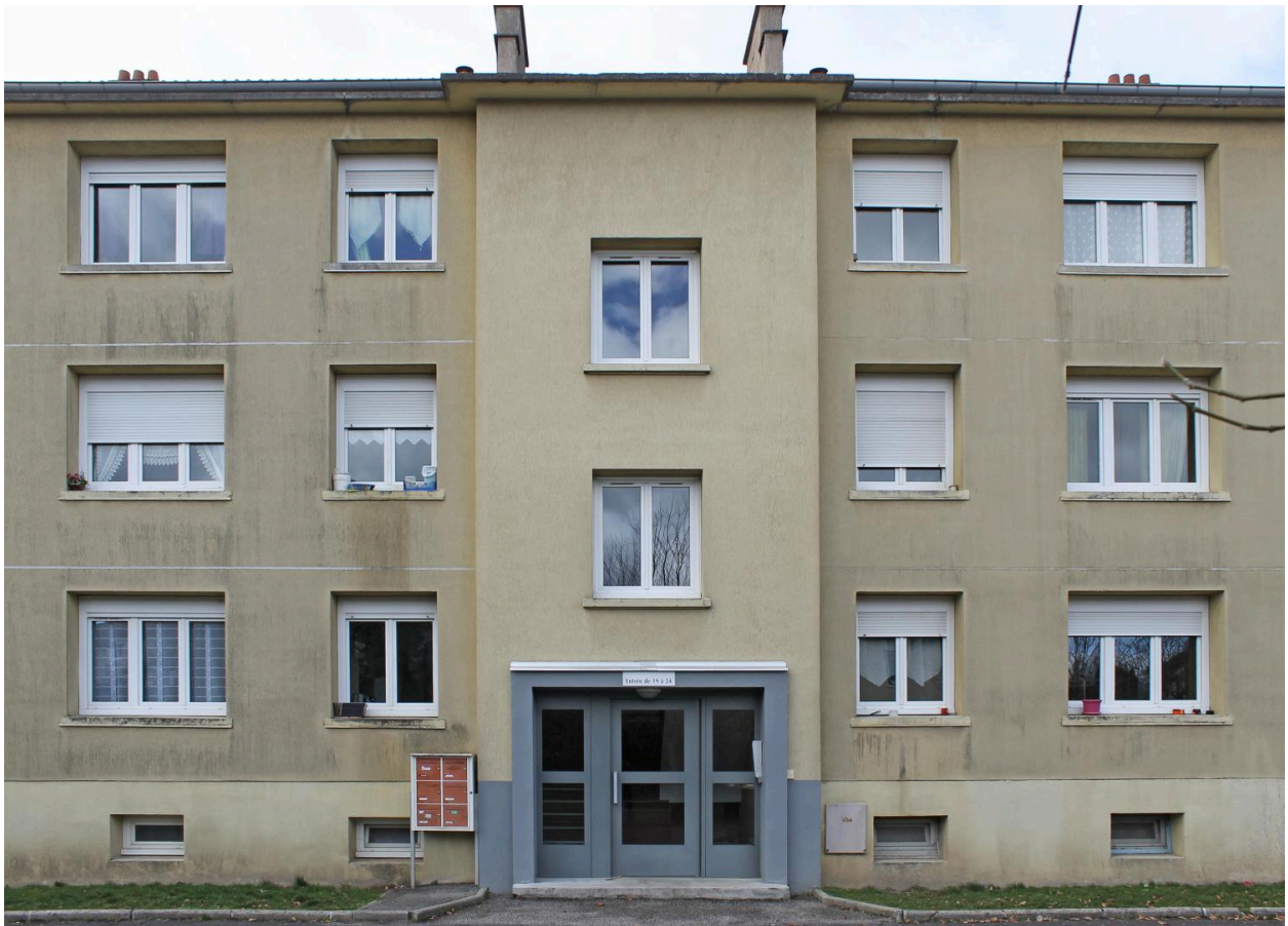
Sainte-Sigolène : les immeubles HLM de la Croix-Saint-Romain et le lotissement Les Érables, l'entrée principale du deuxième module du « Groupe 2 ».
