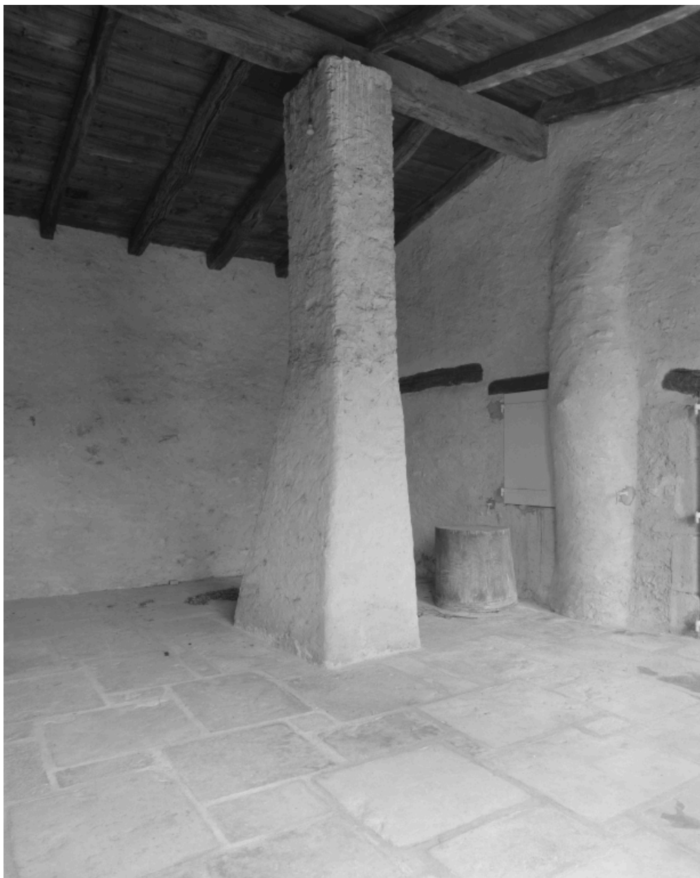
Chèvre, chemin de Taulignan au Poët-Laval. Pilier soutenant la charpente.
