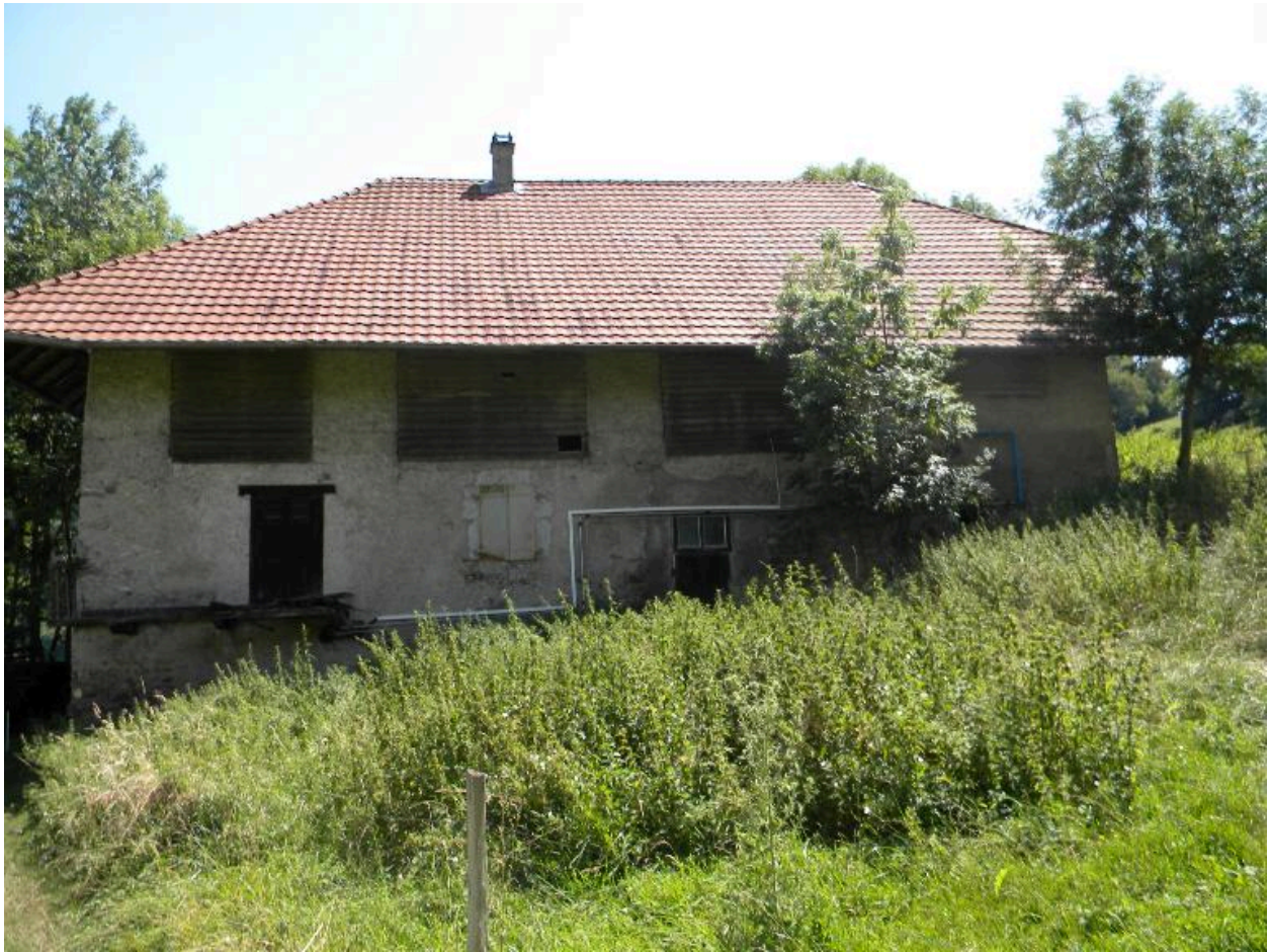
Vue de la façade arrière.
