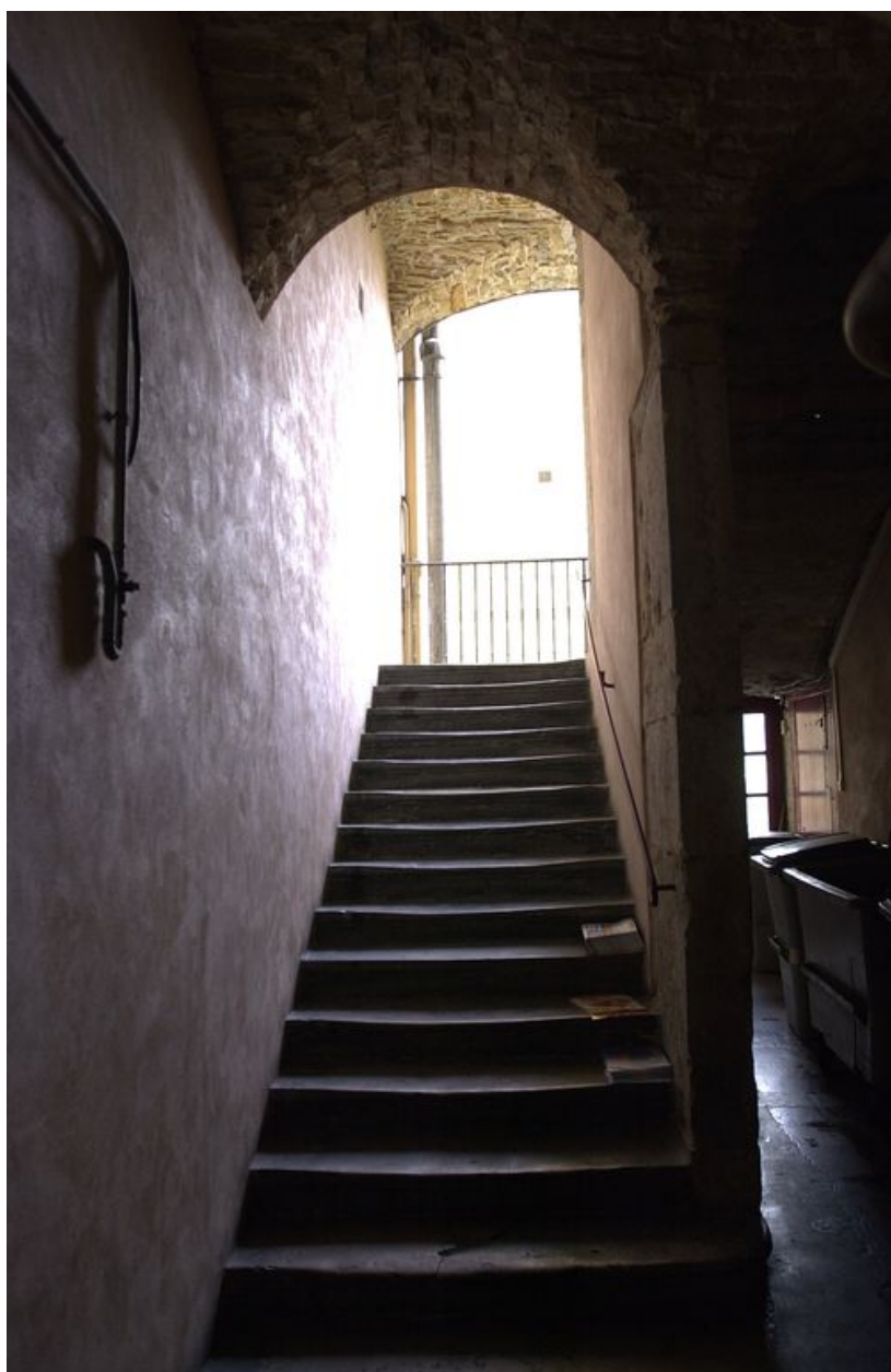
Escalier vu depuis le palier du rez-de-chaussée
