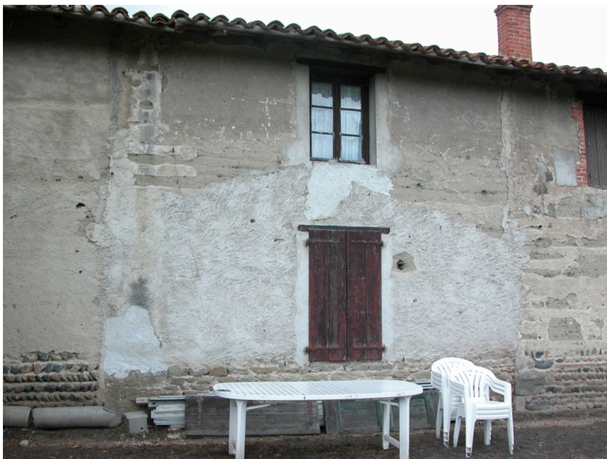
Vue de la travée ajoutée au logis (façade est).
