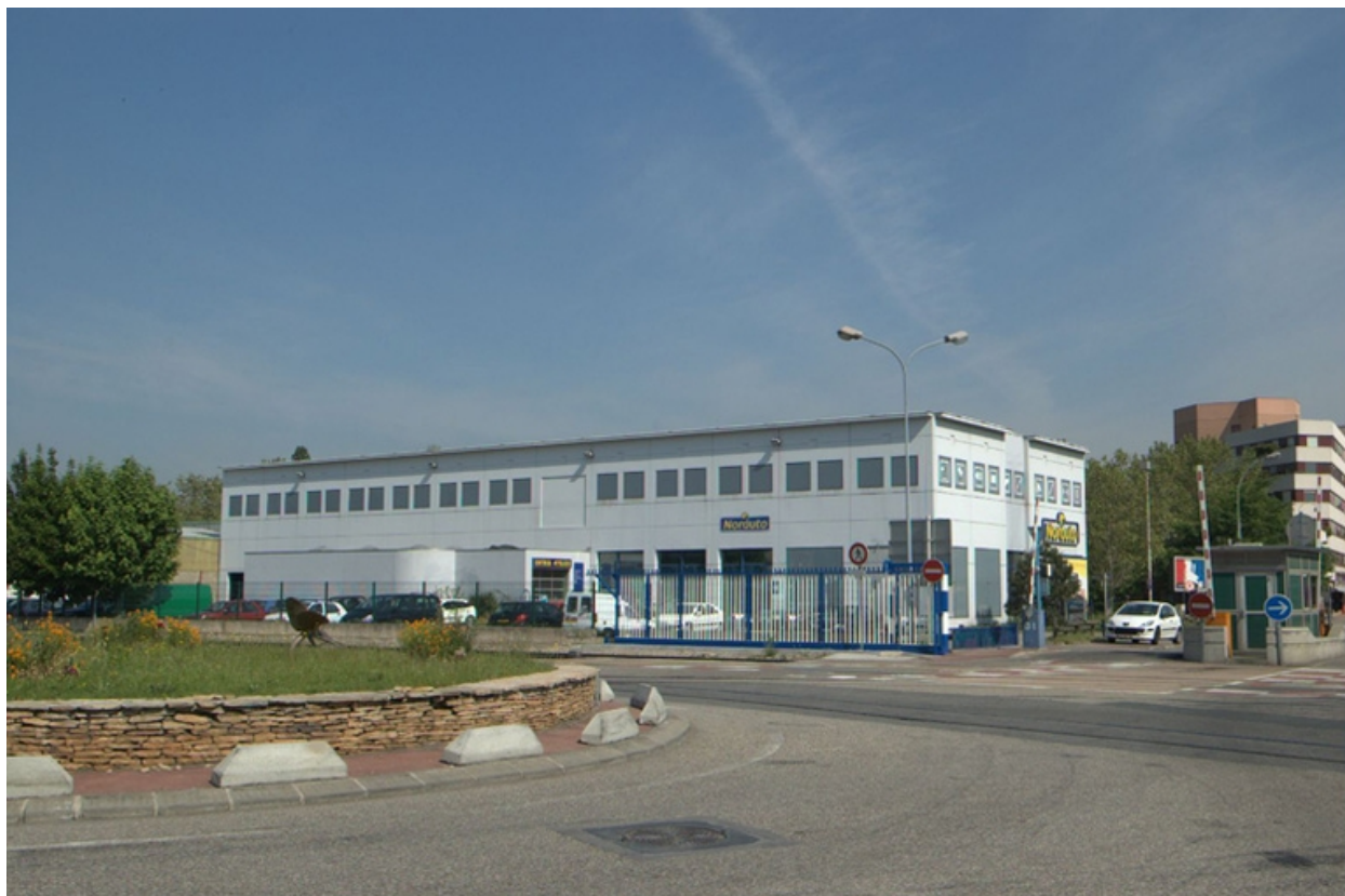
Vue d'ensemble sud de l'entrepôt Norauto
