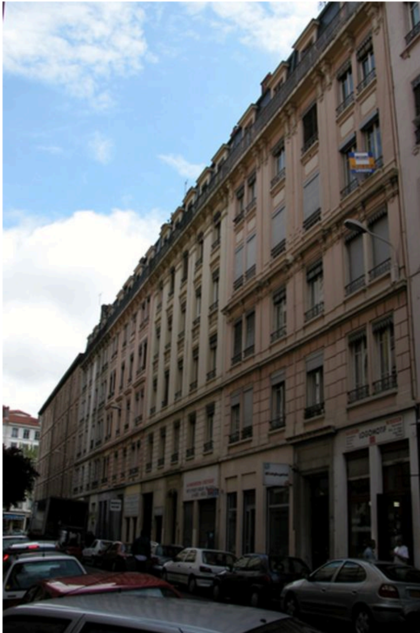
Vue générale de l'élévation sur rue
