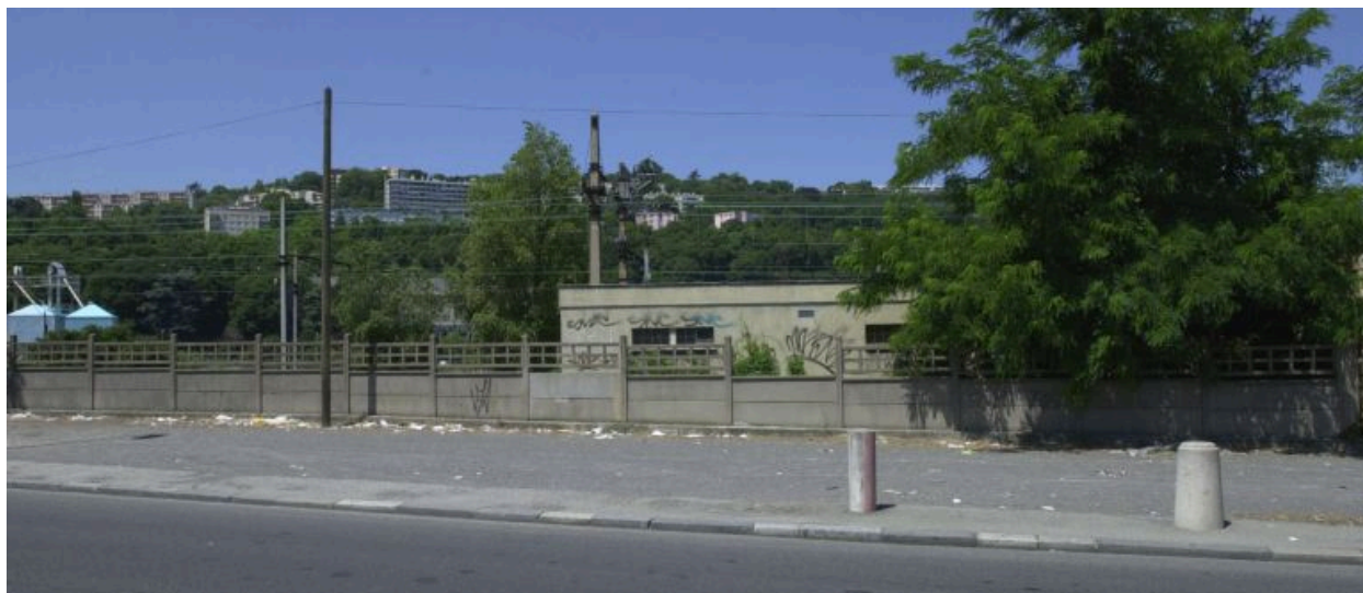
Vue générale depuis l'est
