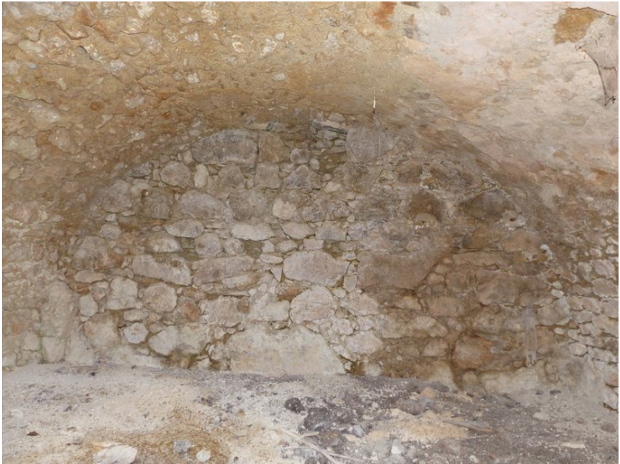
Etage de soubassement, étable. Vue de volume prise du sud.
