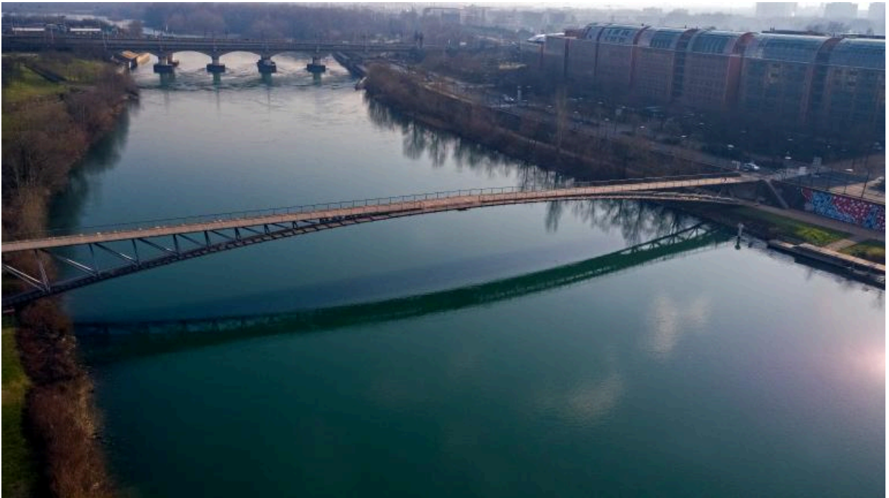
Vue d'ensemble sud de la passerelle de la Paix (drône)
