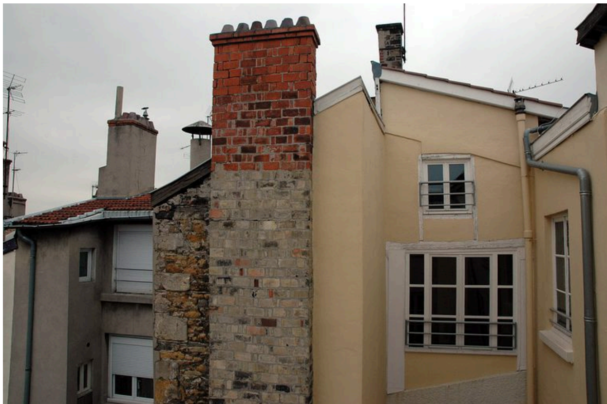
La travée d'escalier ouvrant sur la cour : partie supérieure
