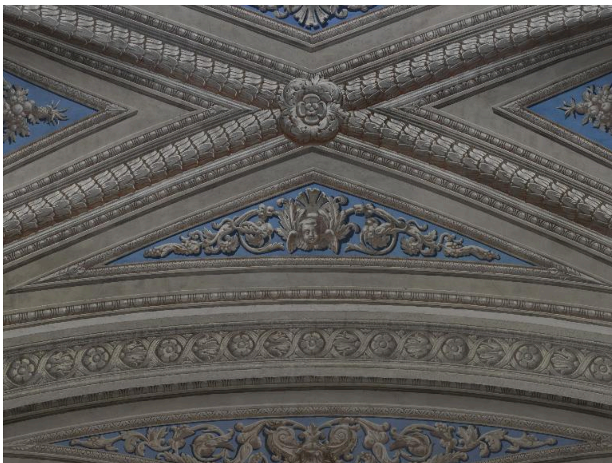
Nef, 1ère travée, partie centrale : détail du faux voûtain ouest
