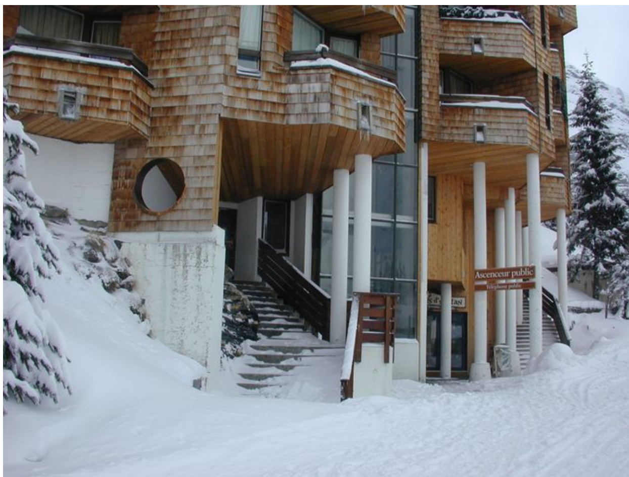
Façade sud : l'accès à la résidence et à l'ascenseur
