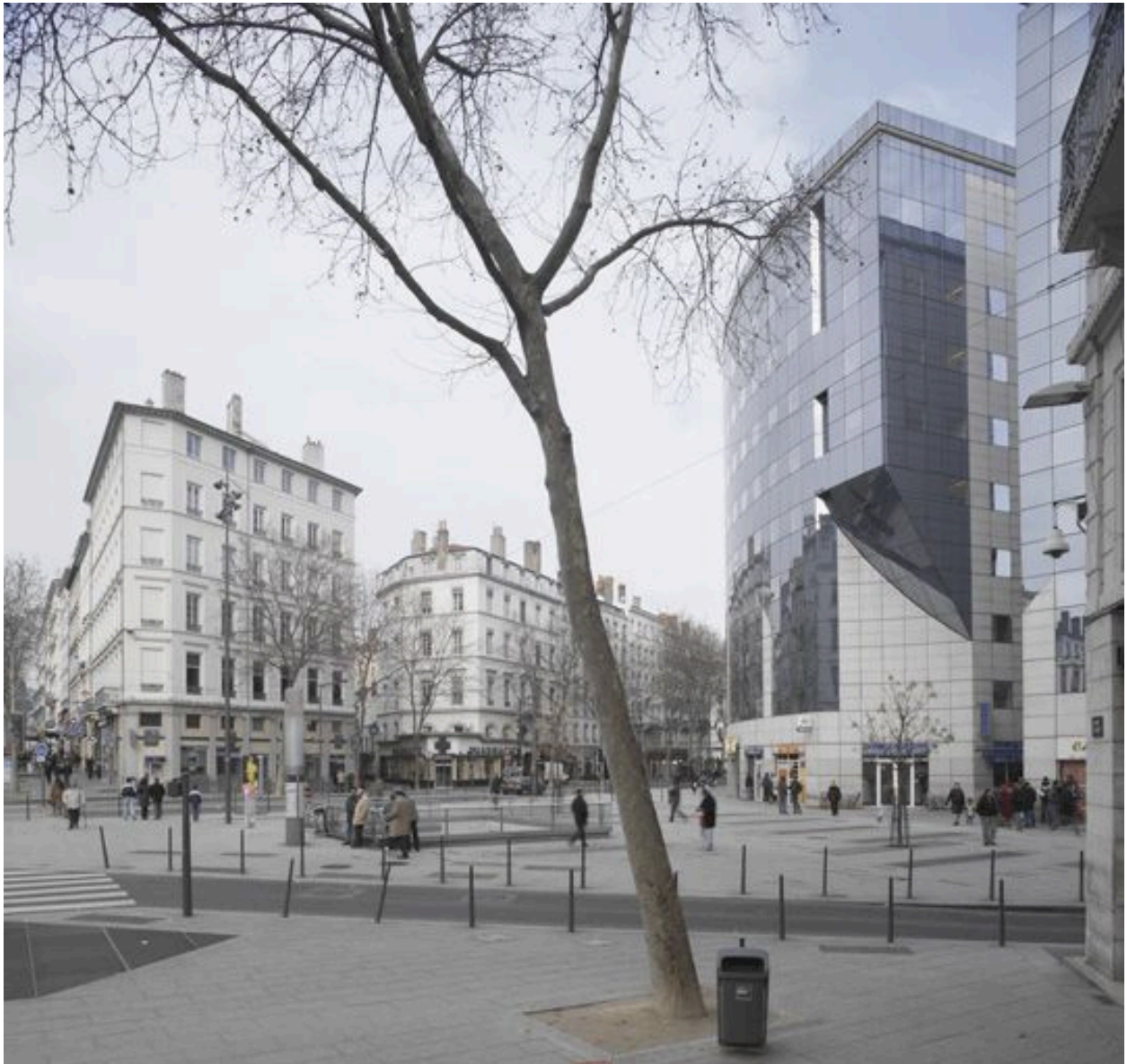
Vue d'ensemble vers le nord et le cours de la Liberté
