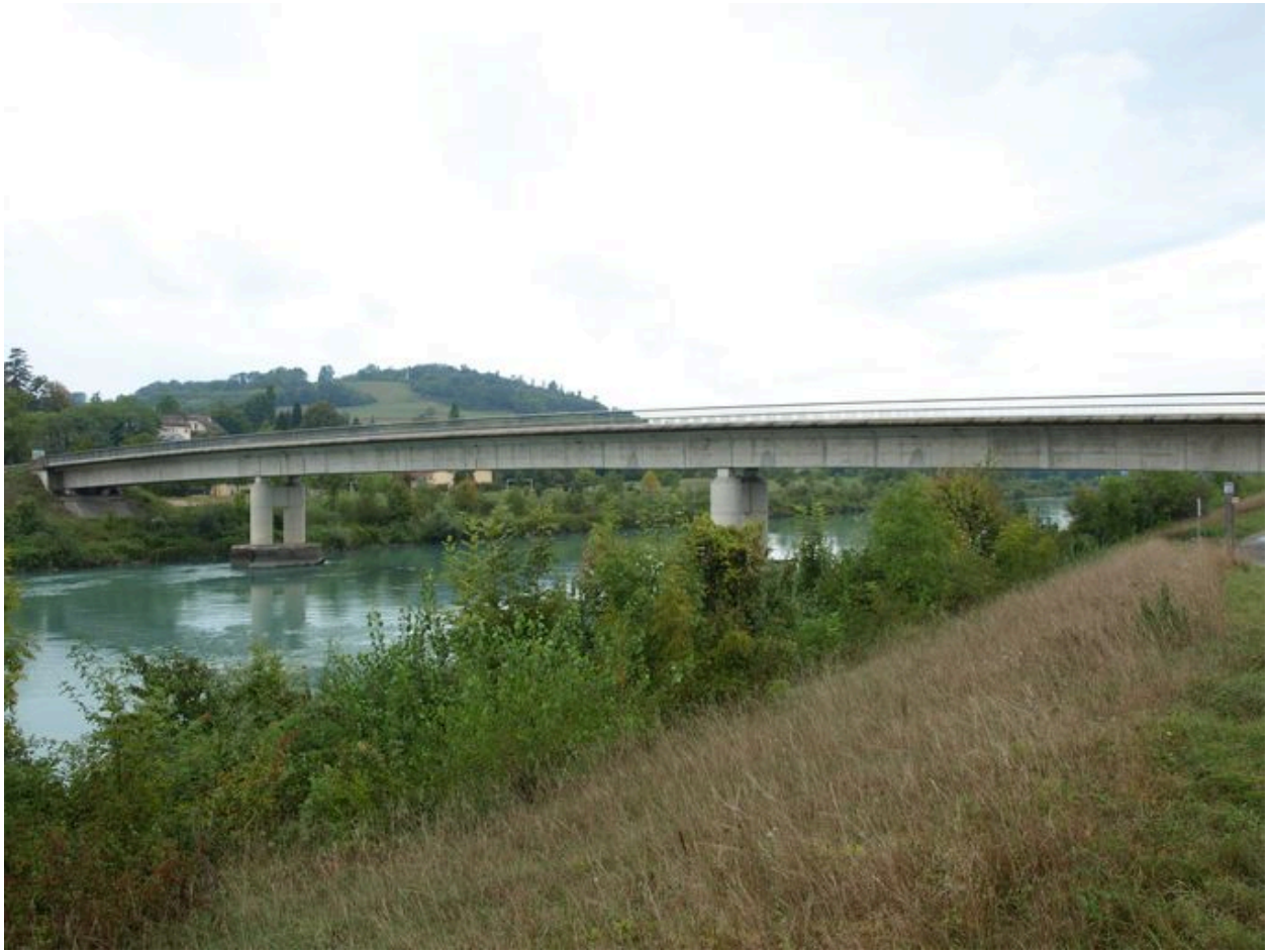
Vue générale, face aval (depuis le rive gauche)
