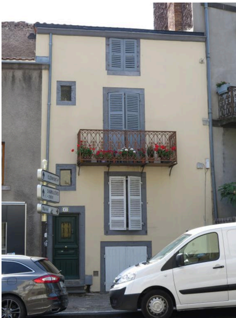
Type "en hauteur" sans escalier extérieur (Chamalières, 47 avenue de Royat)
