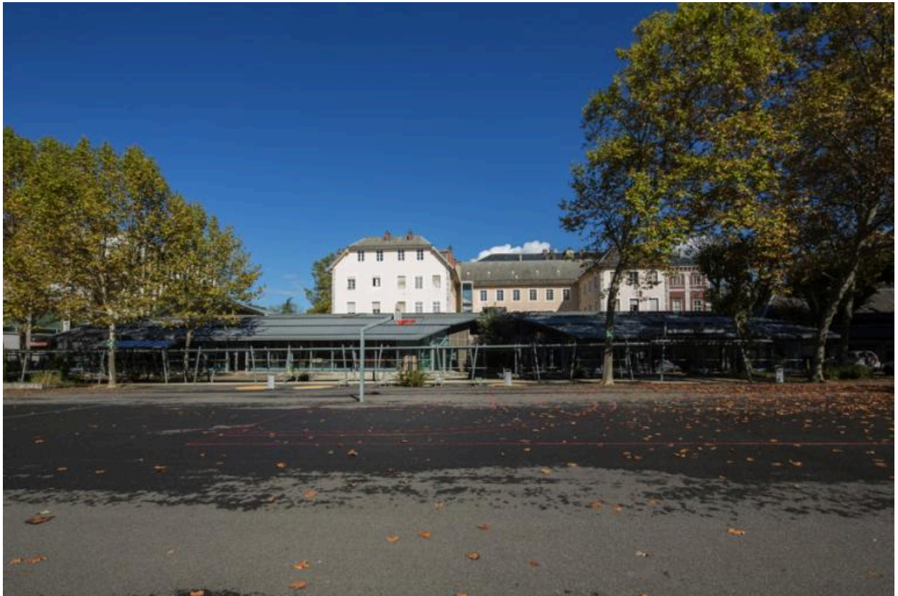
Espace Pierre-Balmain, vue générale extérieure.
