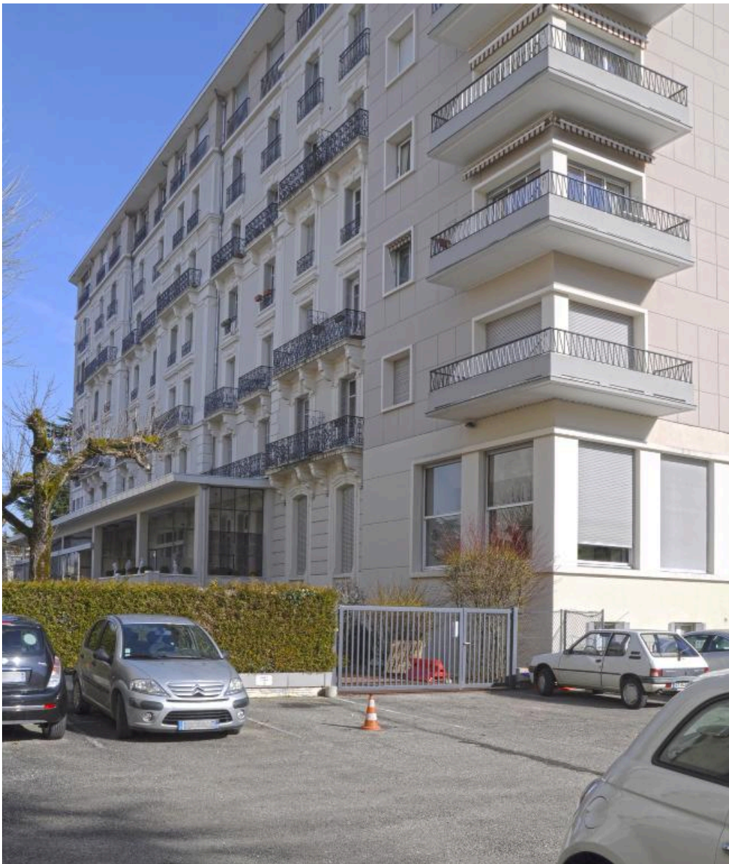
Façade principale (ouest) et latérale (nord)
