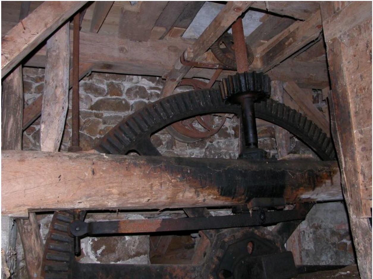
Moulin, étage de soubassement, vue d'ensemble du mécanisme.
