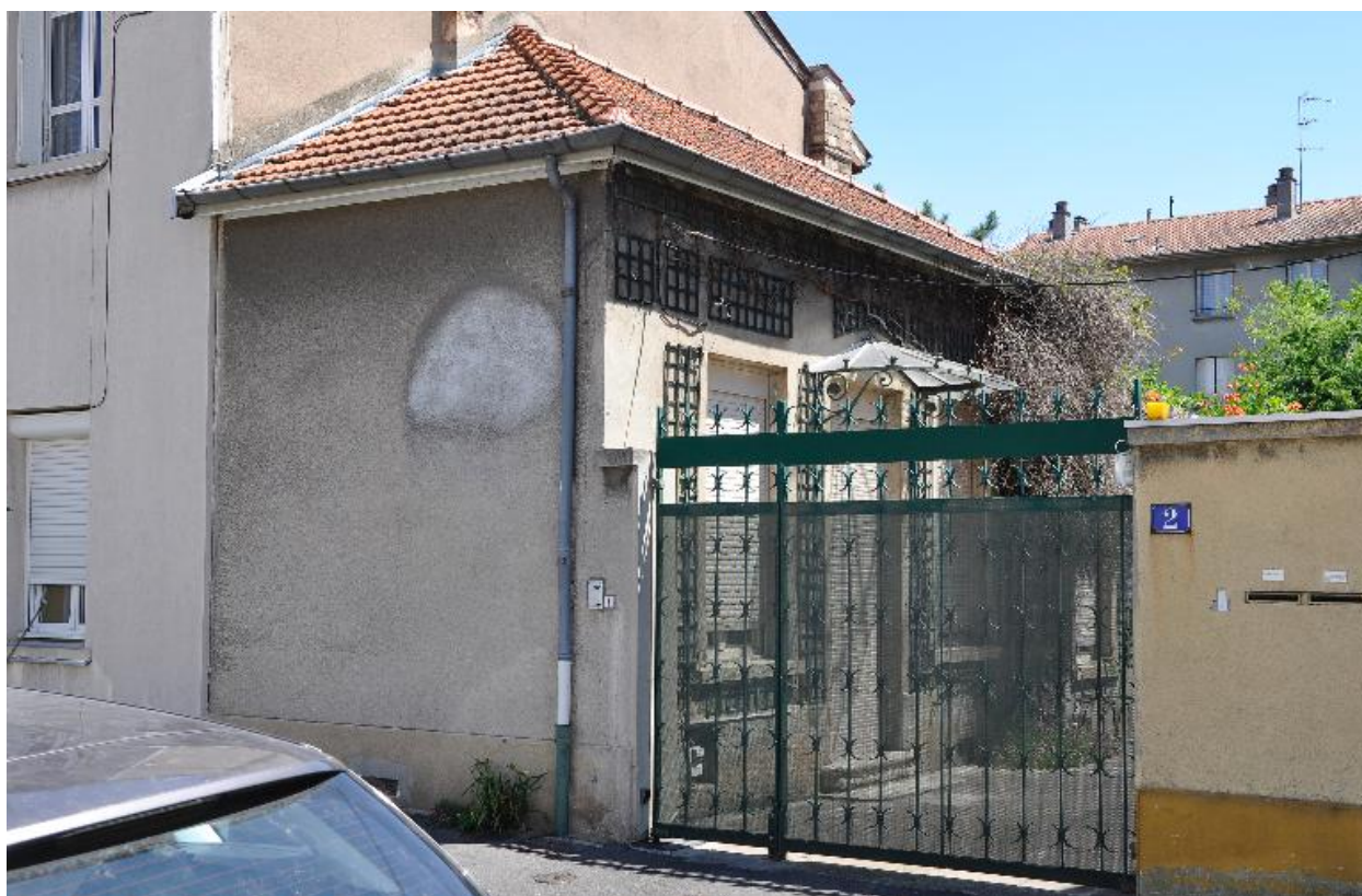
Vue du bâtiment annexe
