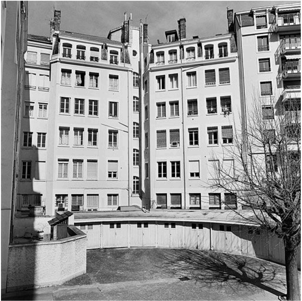
Vue d'ensemble de la cour et des garages
