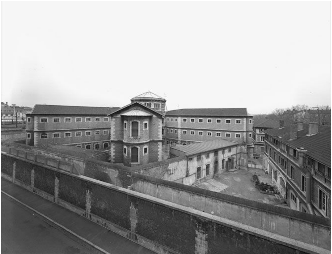
Vue générale prise depuis le deuxième étage de la gendarmerie rue Smith
