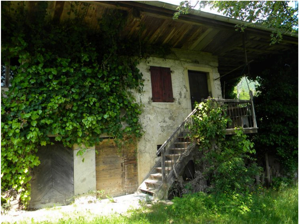
Vue du logis, de la cave et de l'étable.
