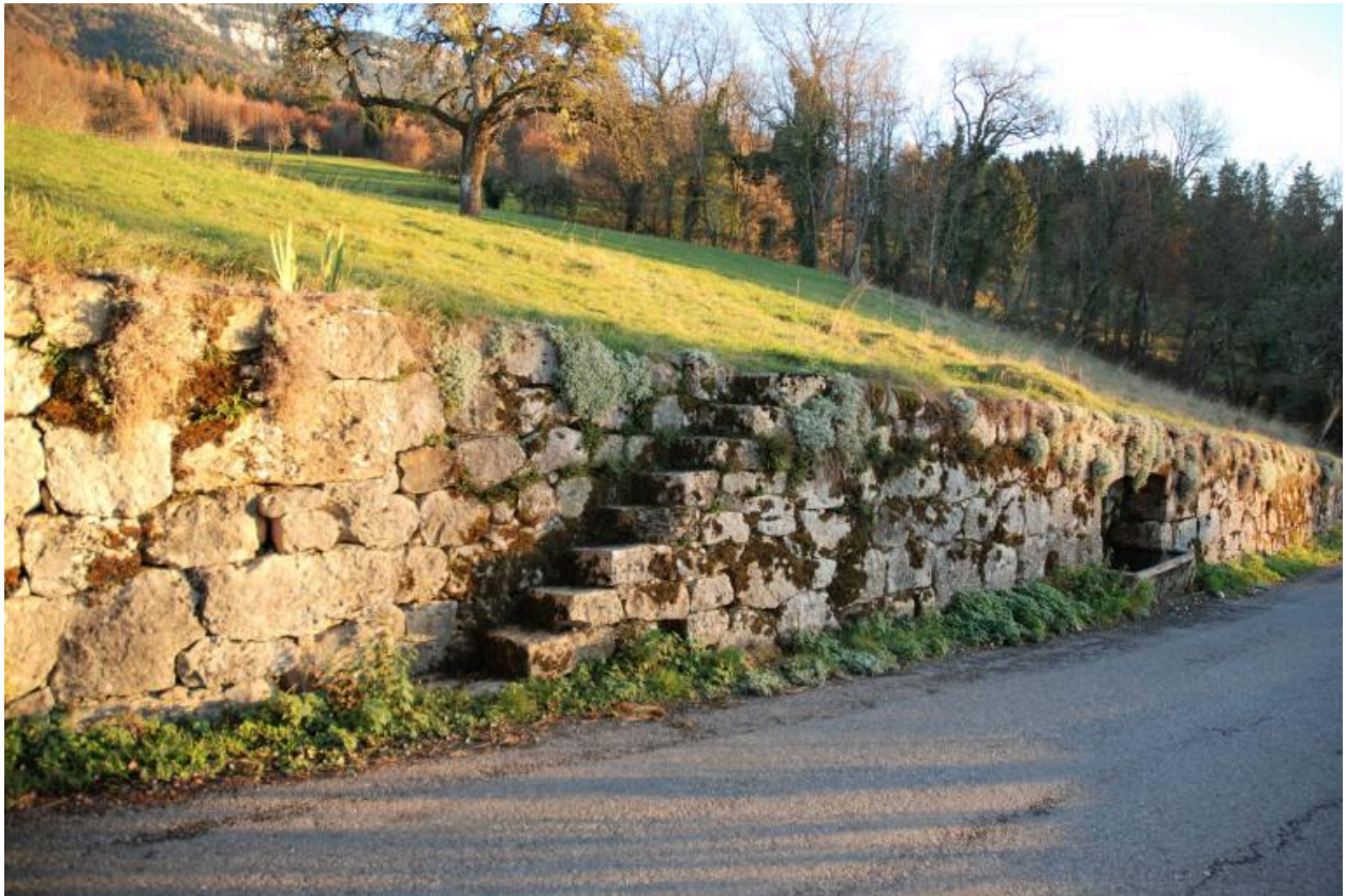
2016 C8 NC (face à 665, proche 1910), bassin. Vue générale avec le mur de soutènement et l'escalier d'accès à la prairie.
