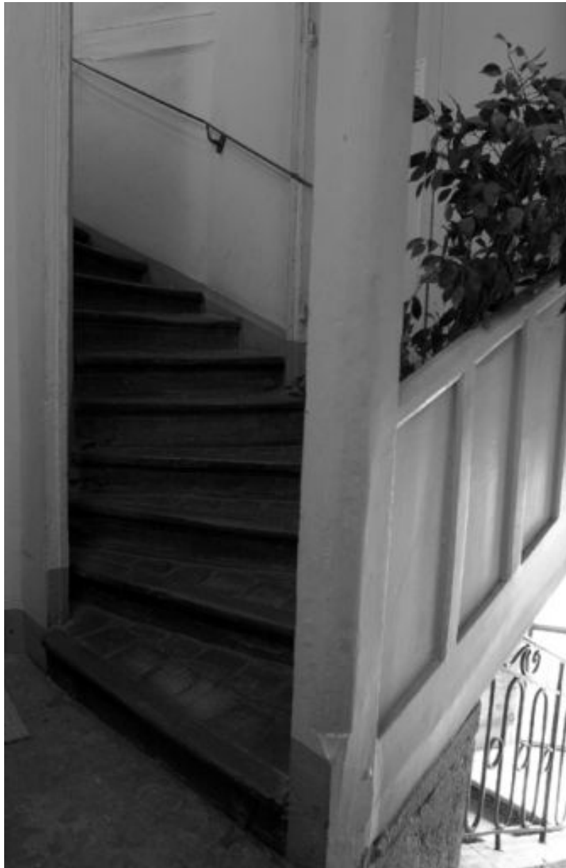
Petit escalier desservant l'étage de combles, au sommet du grand
