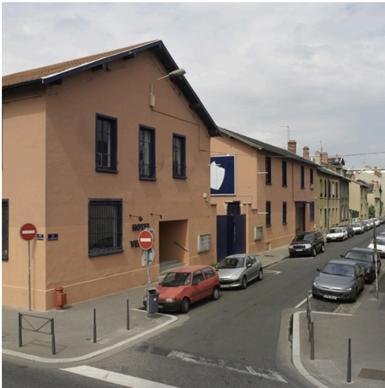
Vue générale sud-est, angle rue du Vivier et rue de Cronstadt
