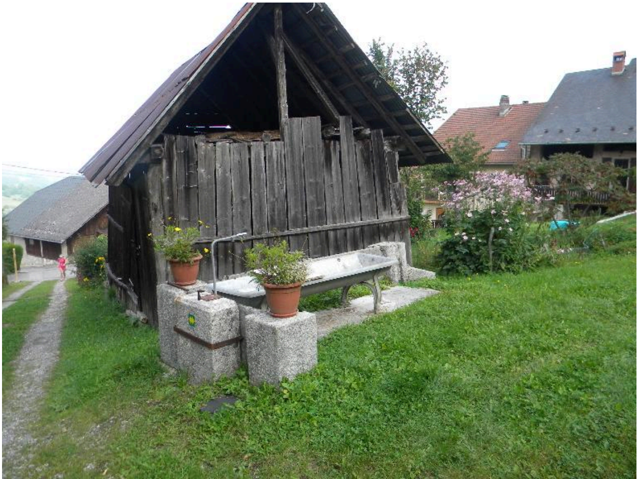
Vue d'une ancienne remise avec les vestiges d'une fontaine en amont. (2008 E8 1055).
