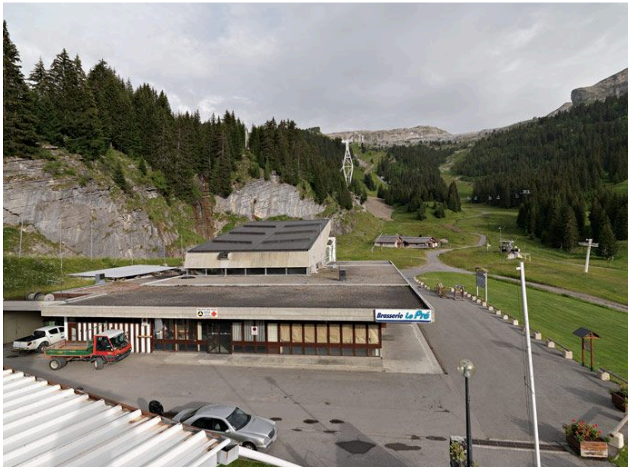
Vue depuis l'ouest
