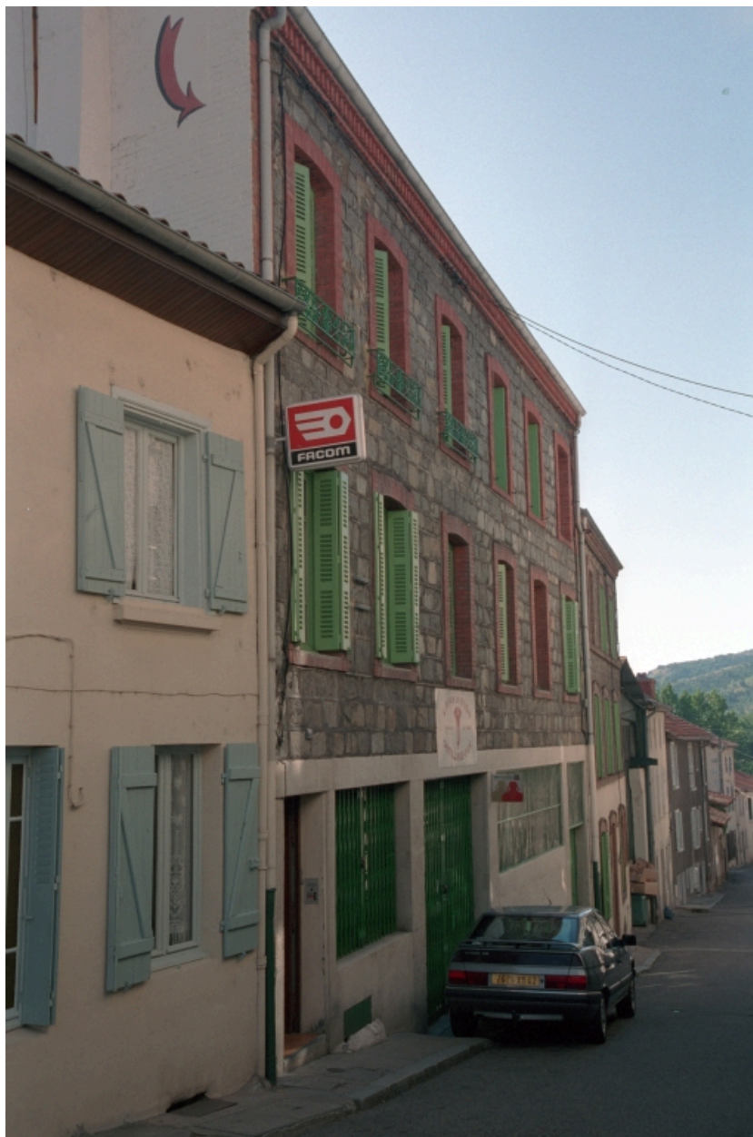
Boën, îlot 13, Ph. Raymond (rue) 12, 14. Vue générale des façades sur rue.
