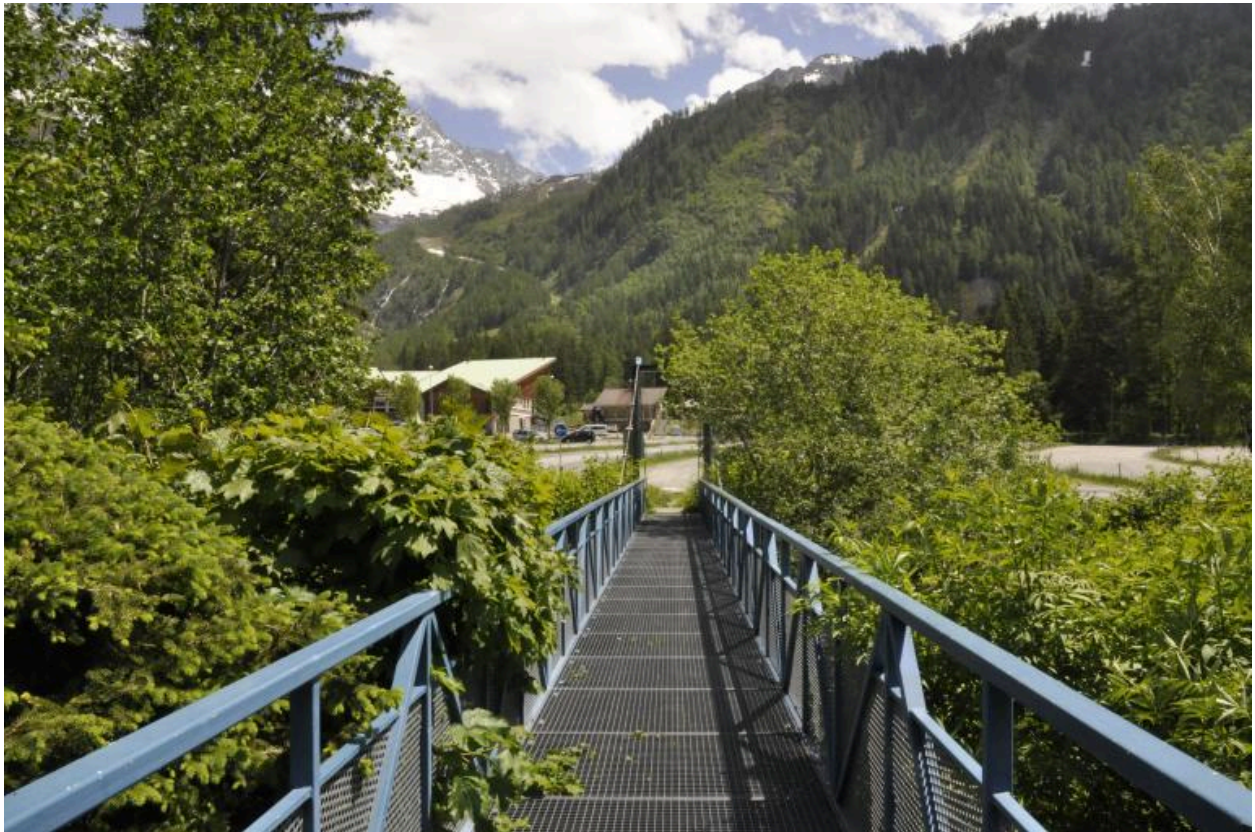
Détail du tablier de la passerelle
