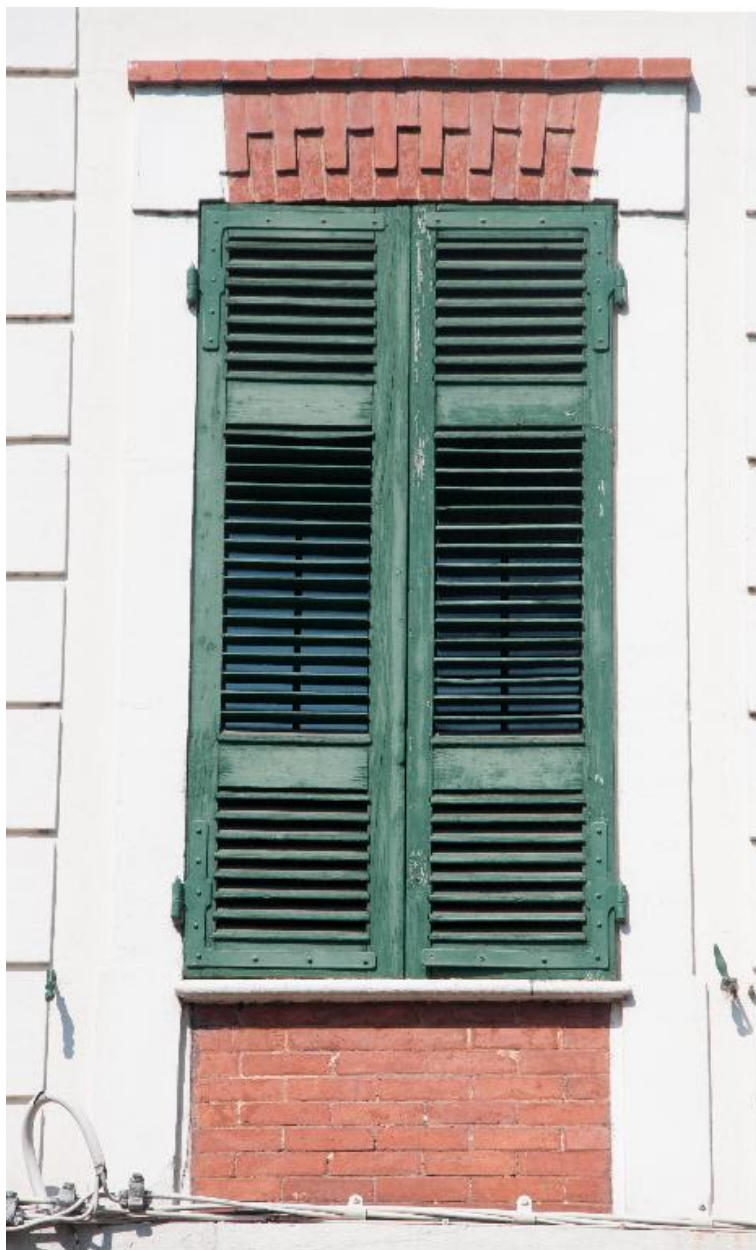
Détail d'une baie au premier étage
